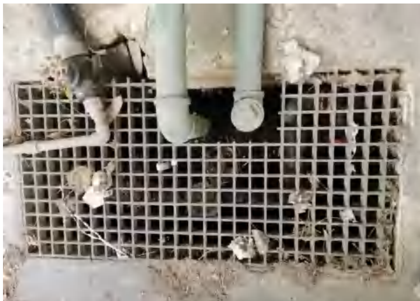
图 4.2-2 事故应急池照片
